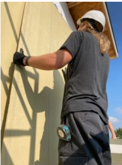
Habitat: Installing Siding
